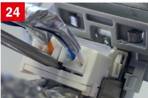
Optional den Schieber mit einem Schraubendreher anheben, die Adern herausziehen und eine Korrektur der Beschaltung durchführen.
